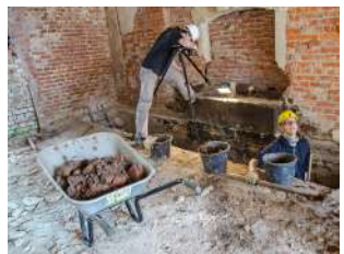
Grabung im Maschinenhaus Tuchfabrik Geb. Pfau, Crimmitschau
